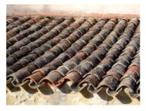
Le débord de toiture éloigne les eaux pluviales de la façade, évitant ainsi le ruissellement sur celle-ci. Il peut être constitué de simples tuiles canal, d'un voligeage\* sur chevrons ou d'une génoise de deux à quatre rangs composée de tuiles canal placées dans le sens des tuiles de couvert.
