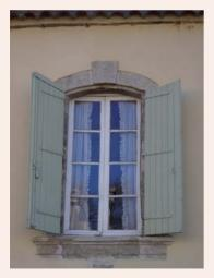
Les fenêtres et porte-fenêtres sont plus hautes que larges et possèdent deux vantaux\* en bois; les carreaux (3 à 4 par vantail) sont rectangulaires verticaux.
