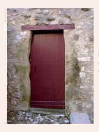
La porte d'entrée de la maison est en bois, simple ou travaillée avec des moulures. Elle est parfois surmontée d'une imposte\* vitrée (ou plus rarement d'un oculus\*) permettant d'éclairer l'entrée.
