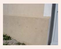
1. Croûte superficielle dure de carbonate de chaux qui se forme à la surface des pierres calcaires sous l'action de l'air et des intempéries après la taille. Cette couche, épaisse et résistante, agit comme une protection naturelle des pierres.
