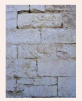
**Le soubassement** protège l'enduit des salissures. Il est réalisé en surépaisseur et dressé au mortier de chaux hydraulique de teinte moyenne, plus foncée que celle des murs.
