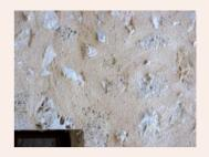
Le mortier de ciment ne convient pas aux murs anciens et les empêche de respirer, provoquant de l'humidité et des décollements.
