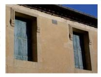
1. Liant obtenu par calcination du calcaire : les chaux se divisent en 2 catégories bien distinctes, selon que leur prise s'effectue sous l'action du gaz carbonique de l'air (chaux aérienne : prise lente), ou sous l'action de l'eau (chaux hydraulique : prise plus rapide).
